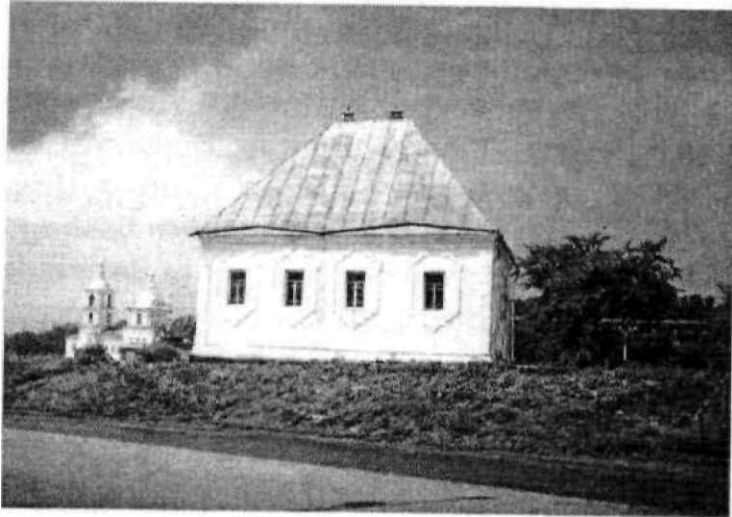
Der erste Steinbau im Kusbass. Der ehemalige Fiskus . Erbaut 1780
